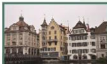
Mehrfamilienhaus Krongasse 2 / 4 6003 Luzern
