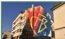
Mehrfamilienhaus Lothringerstrasse 6 4056 Basel
